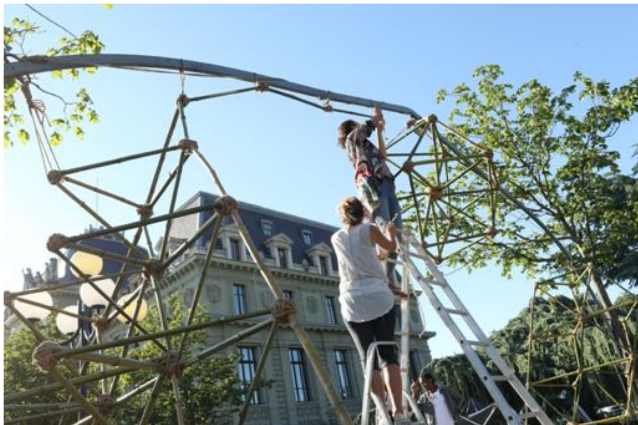
Confection d'une arche : assemblage de bambous et cordes sur une armature métallique Festival de la Terre 2019, Lausanne (CH)
