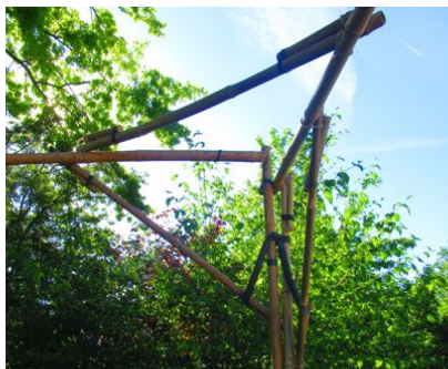
Armatures de tonnelles : assemblage de bambous, chambres à air et cordes Festival de la Terre 2019, Lausanne (CH)
